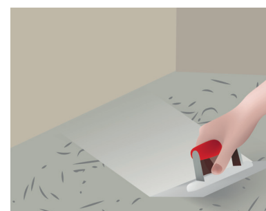
USUWANIE NIERÓWNOŚCI - BETON
