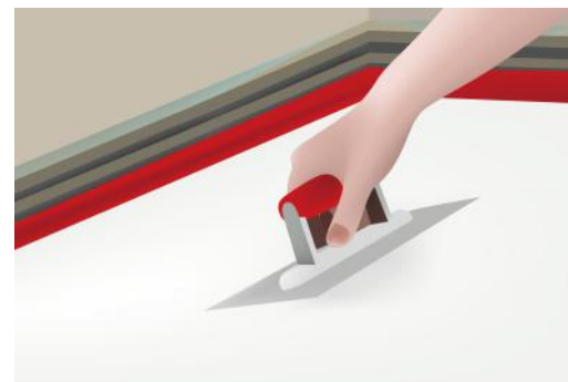
UKŁADANIE PŁYTY TERMO-TOP
